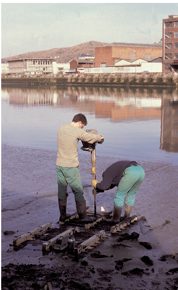
Figura 3-3: Perforación del sondeo Zorroza (PCZ) en la Ría de Bilbao.
