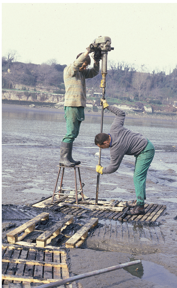
Figura 3-7: Detalle de la perforación en el área de Erandio (PCE).
